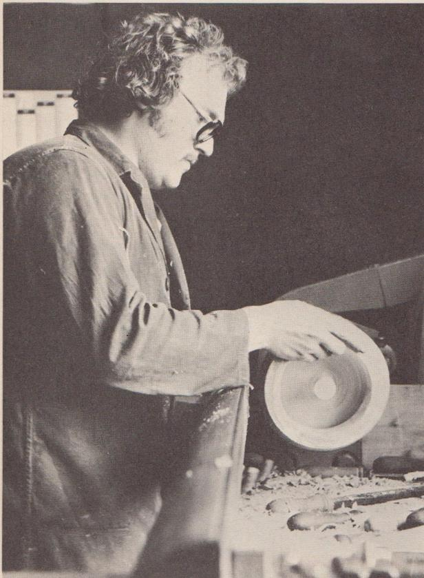
Der Ring wird aufgesetzt und so fixiert, dass er rund dreht
